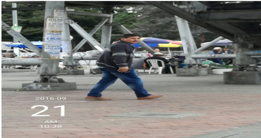
Fotografía No.3. Detalle de los elementos instalados en Mobiliario Urbano (Poste).Visita de oficio en la Localidad de Engativá, día 21 de septiembre de 2016.
